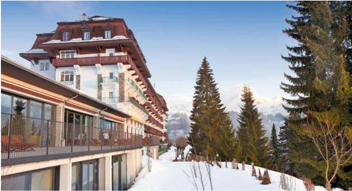
Le futur nouveau palace souhaite s'adresser à une clientèle aussi large que possible. Sa réouverture, après rénovation, est attendue pour la mi-décembre.
